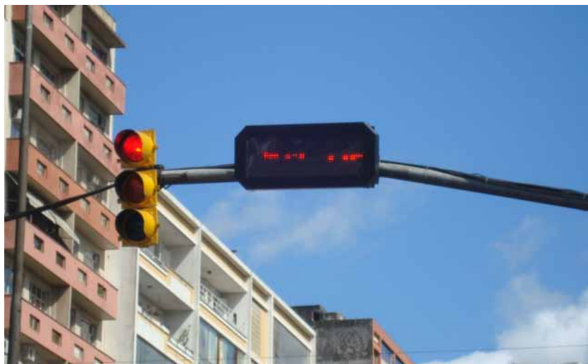
Painel de mensagem variável fixado junto ao semáforo.
