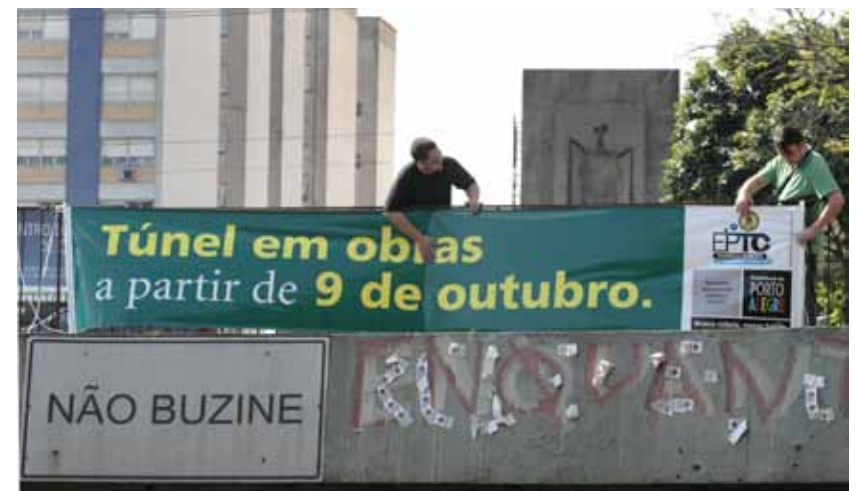
Faixa informando sobre o início das obras
