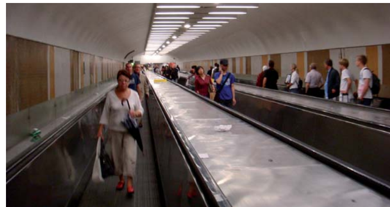
Figura 7 Esteira rolante em metrô de Paris, França. Sentidos alternados conforme a demanda dos fluxos
