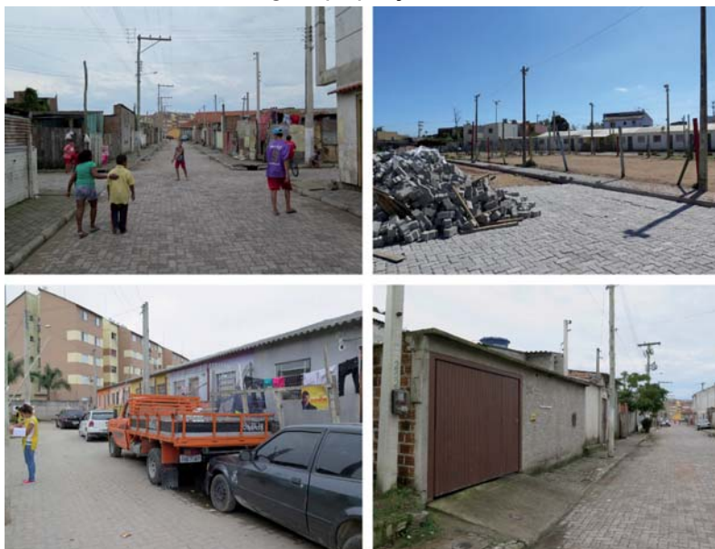
Figura 5 Vias do loteamento PAC/Anglo. Apropriações, características
