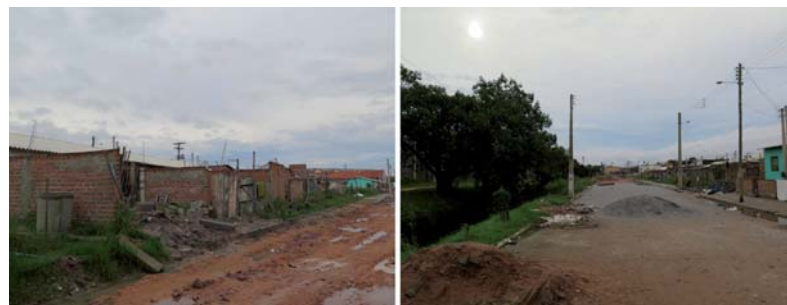
Figura 4 Vias do loteamento PAC/Anglo. Infraestrutura viária inexistente ou incompleta após a entrega das casas
