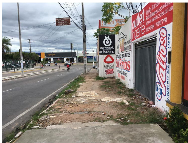
Figura 01. Calçada no Bairro Triângulo, Juazeiro do Norte.
