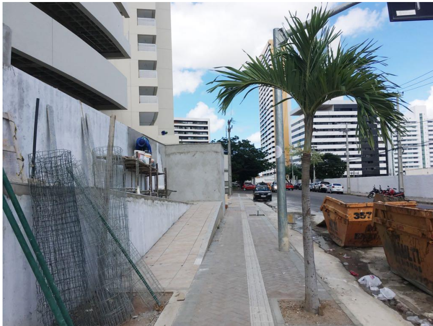
Figura 02. Calçada do Condomínio Unique, Juazeiro do Norte.
