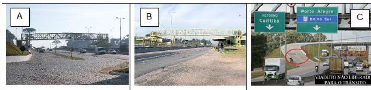
Figura 4: A – Passarela km 115, B Passarela km 118, Fonte: autores, 2018 e C – Viaduto da Vila Pompeia, no Tatuquara, Km 118,5. Fonte: Tribuna do Paraná, 2019.
