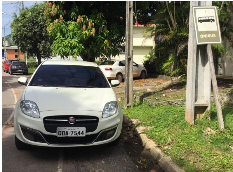
Figura 3 – Ponto de parada sem calçada, abrigo, bancos e recuo, além da placa deteriorada, no setor básico.
