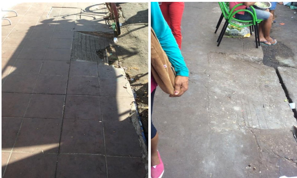
Figura 5 – Rampas existentes na região
