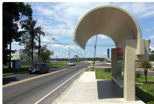
Figura 03: Parada de ônibus em concreto. Fonte: J.Nasser Engenharia,2017.
