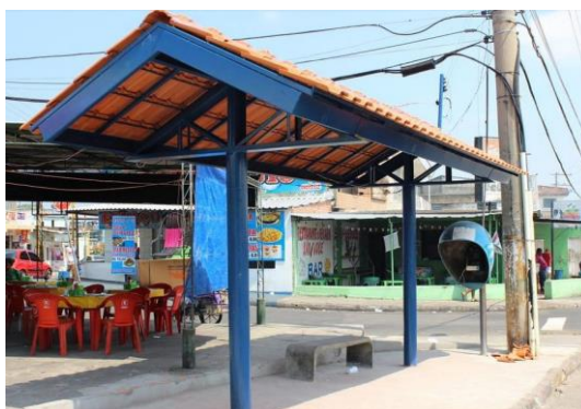
Figura 01: Parada de ônibus com cobertura em telha de barro. Fonte: SMTU.
