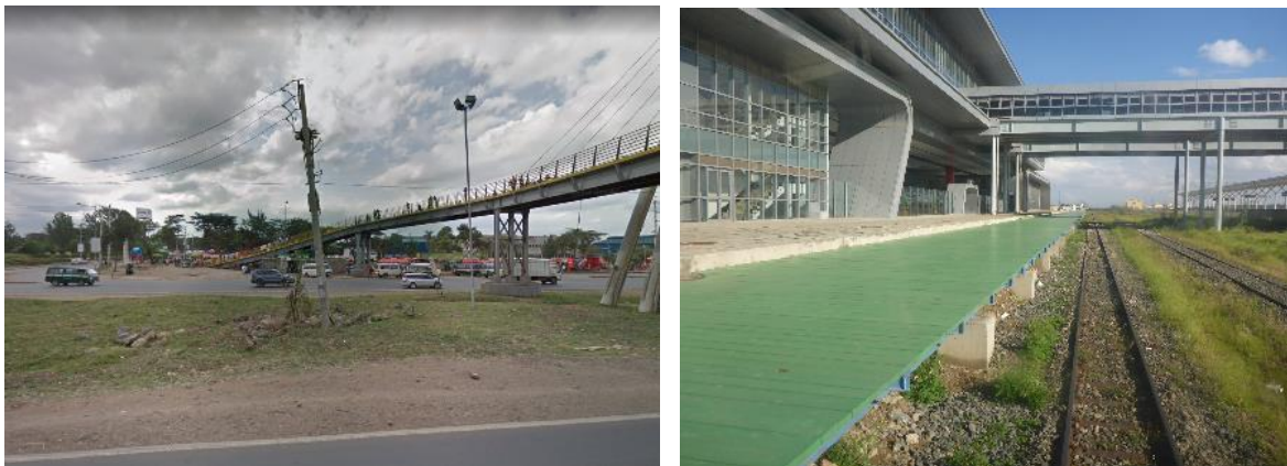
Figura 3 - Parada de matatus próximo à passarela / Plataforma de embarque e desembarque do serviço metropolitano no Terminal SGR
