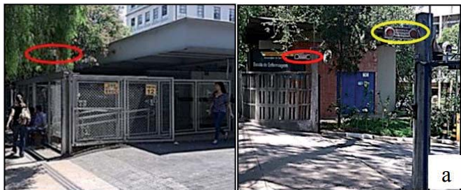
Figura 13 Sinal luminoso pouco visível; com dispositivo sonoro
