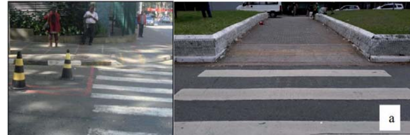
Figura 6 Calçada localizada na rua Particular; modelo de calçada adequada
