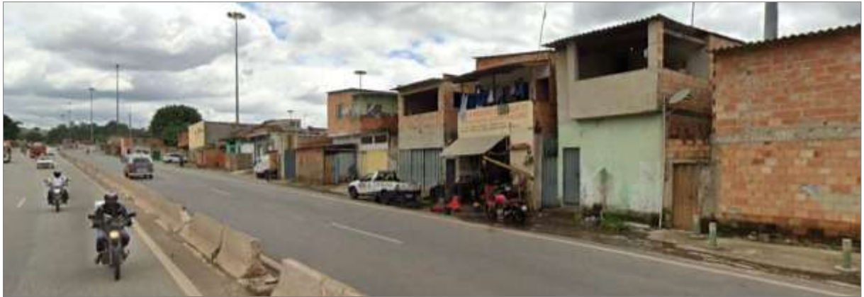
Figura 4: Ocupação Vila da Luz, localizada na margem do Anel Rodoviário de Belo Horizonte. Fonte: Google Earth (2021).
