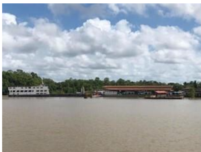
Figura 4: Porto do Camará – Ilha do Marajó Fonte: Autores, 2021.
