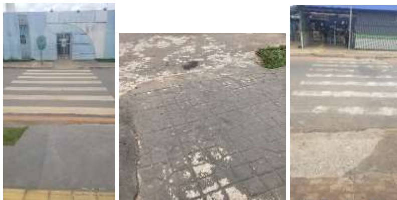
Figura 6 – Rampas para acessibilidade universal inadequadas
