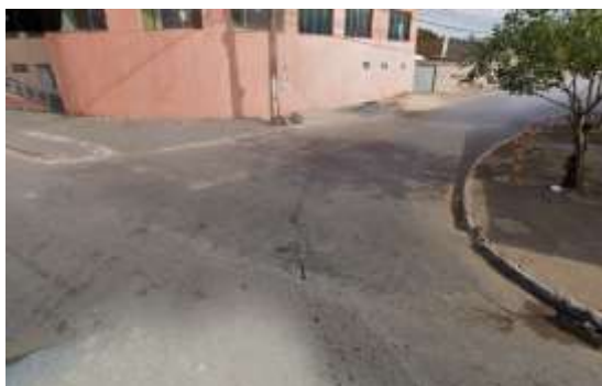
Figura 11 – Sinalização Horizontal da Av. Senador Canedo X Rua JM 20
