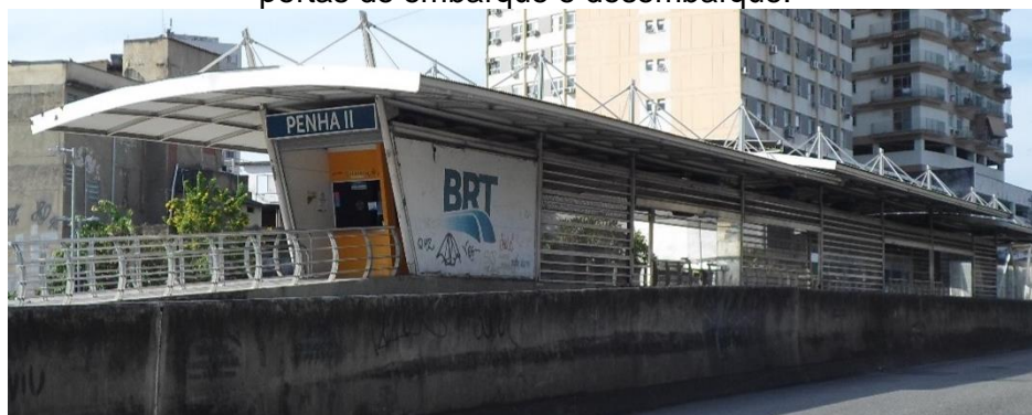
Figura 9 – Módulo Parador da Estação Penha II pichado e com os vidros quebrados das portas de embarque e desembarque.
