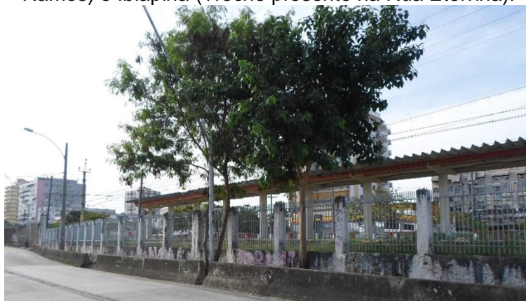
Figura 13 – Calçada com árvore e poste no trecho entre as estações Olaria (Cacique de Ramos) e Ibiapina (Trecho presente na Rua Etelvina).
