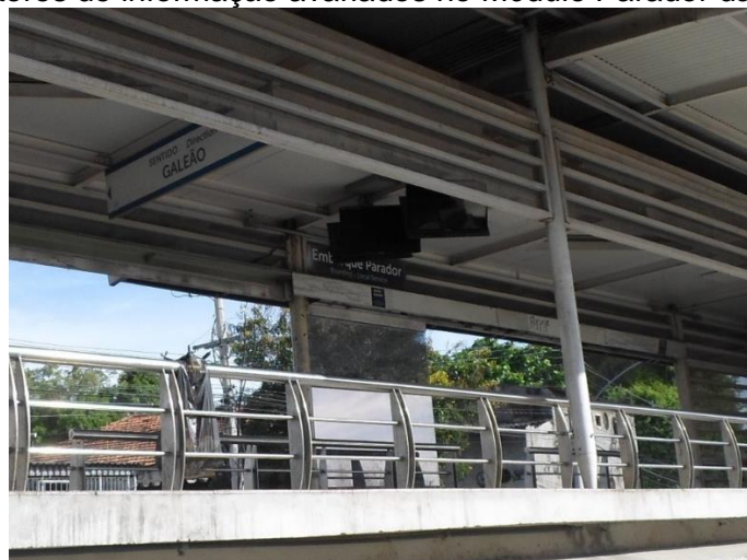
Figura 11 – Monitores de informação avariados no Módulo Parador da estação Penha II.
