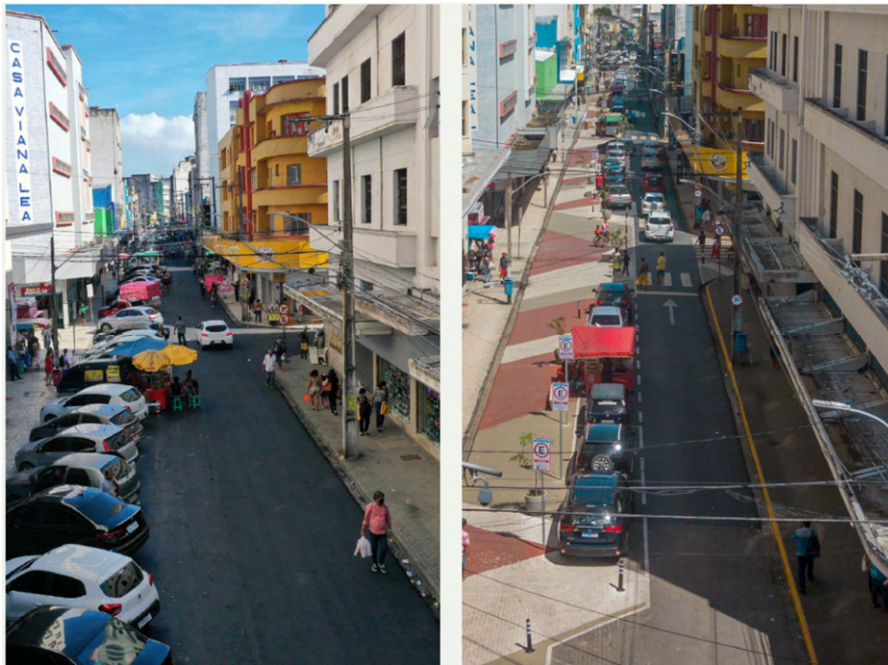
Figura 8: Rua da Palma antes e depois da intervenção, Recife. Fonte: CTTU, 2023, p. 250
