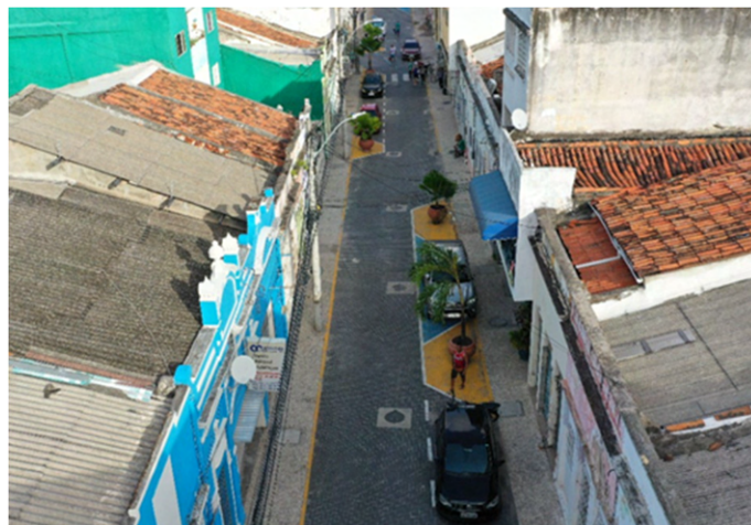
Figura 5: Utilização de chicanas na Rua Velha, Recife. Fonte: CTTU, 2023, p. 336
